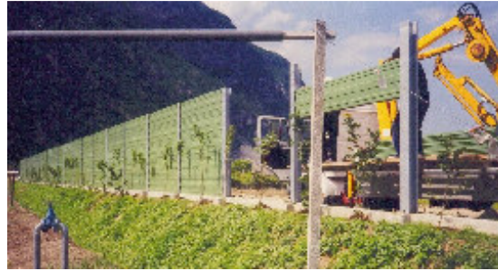
Fig. 1.6: Instalarea de bariere acustice de-a lungul drumului
