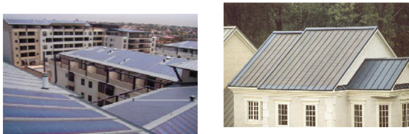
Fig. 1.10: Exemple de aplicații cu panourile fotovoltaice Metecno
